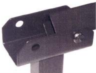
Sistema de unión mediante bulón
